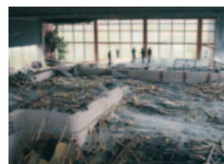
Nel 1985 a Uster, Svizzera, il controsoffitto in cemento di una piscina coperta cedette. Le sospensioni del soffitto in acciaio inossidabile non mostravano esternamente alcuna imperfezione, ma internamente, la corrosione sotto tensione ne aveva causato la parziale distruzione.
