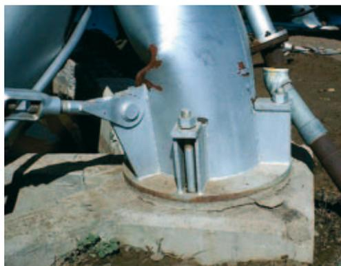
Figura 6: Ancoraggio chimico di una carpenteria metallica dopo un evento sismico
