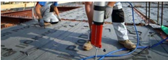
1. Particolare di iniezione della resina nei fori appena realizzati.
